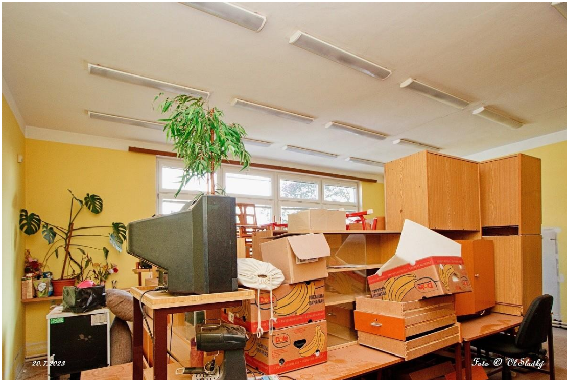
Rekonstrukce a modernizace budovy DDM: červen - září 2023
